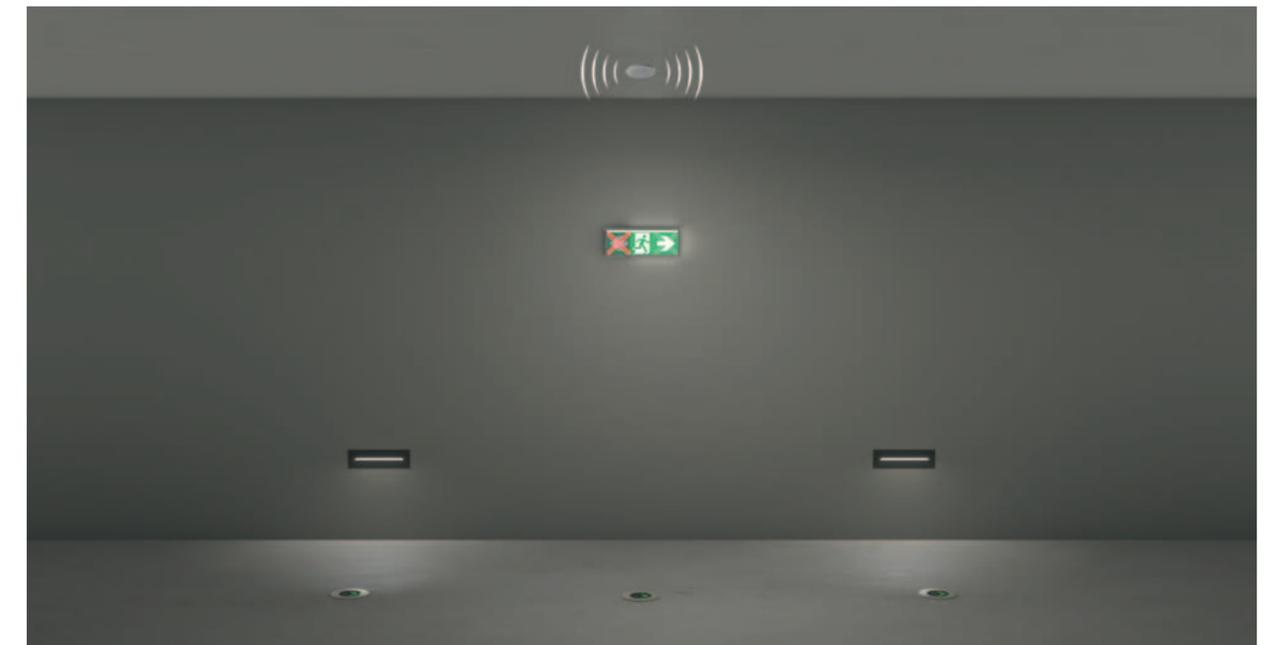
Auf Basis einer Gefährdungsbeurteilung kann zusätzlich eine richtungsvariable Fluchtweglenkung (dynamisch oder adaptiv) sowie eine Signalisierung nach dem Zwei-Sinne-Prinzip für eine barrierefreie Gebäudenutzung bzw. als Unterstützung in Gefahrensituationen gefordert sein. Die Vorschriften DIN 14036, DIN CEN/TS 17951, DIN VDE V 0108-200 und die ASR A2.3 beinhalten konkrete Anforderungen zur Planung, zur Umsetzung und für einen dauerhaft funktionstüchtigen Betrieb.
